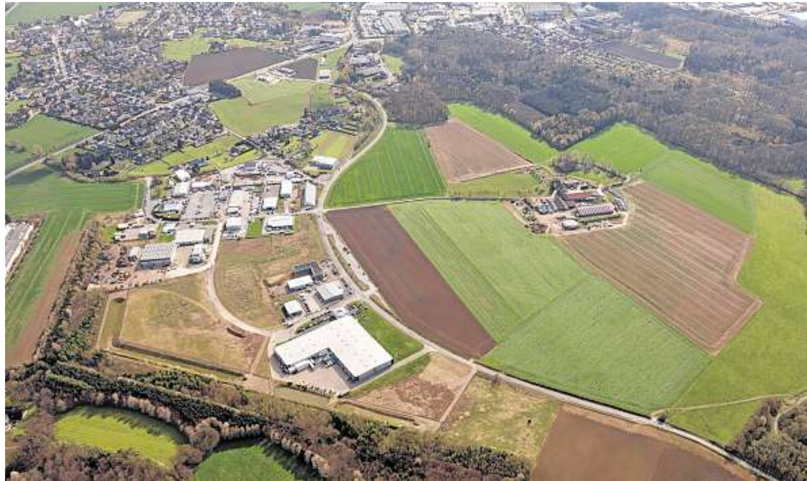
Das Gewerbegebiet Hämmer aus der Vogelperspektive. Die Erweiterung wird derzeit vorbereitet.
